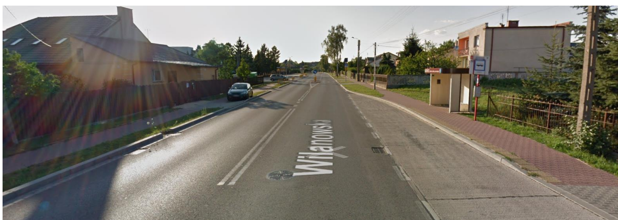
Rys. 6.11. DW724 – przebieg przez miejscowość Brzeście źródło: google street view
