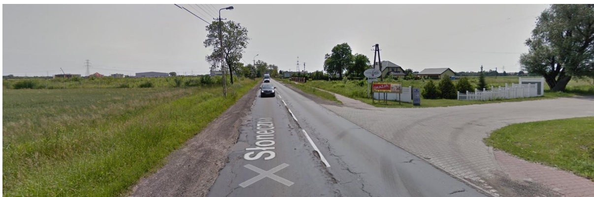
Rys. 6.7. DW721 – przebieg w gminie Lesznowola źródło: google street view
