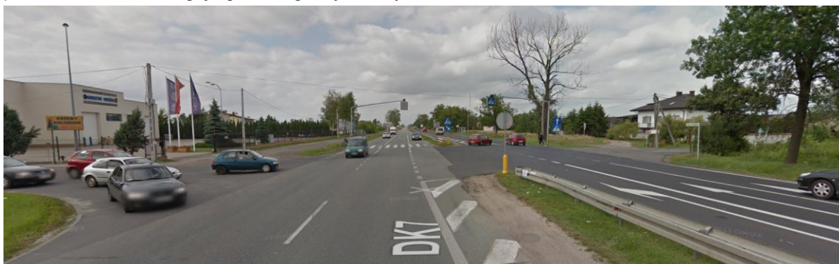
Rys. 6.2. Skrzyżowanie na drodze DK7 źródło: google street view
