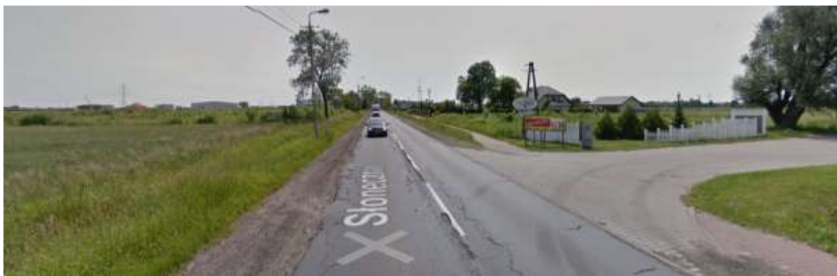
Rys. 5.7. DW721 – przebieg w gminie Lesznowola źródło: google street view
