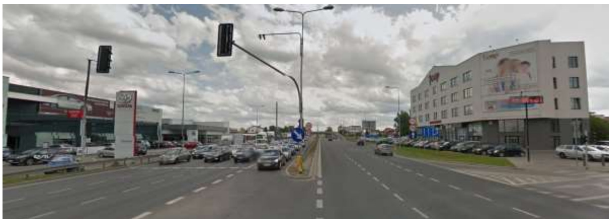
Rys. 5.4. DK79 – ulica Puławska rejon skrzyżowania z ul. Geodetów źródło: google street view
