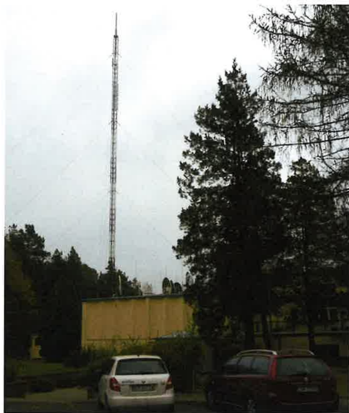
Fot. 1. RCN Raszyn – widok obiektu
