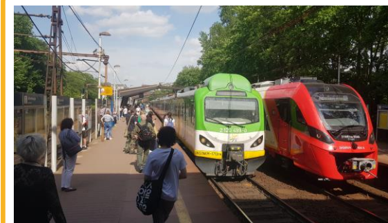
Rys. 2.7 Infrastruktura kolejowa PKP Powiśle w Warszawie
