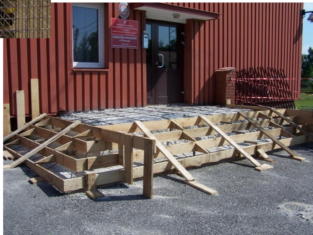
Remont generalny schodów
