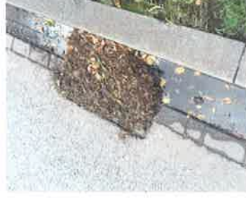
Stan po jesiennym deszczu. Igliwie jest wszędzie i nie zebrane musi wpaść do studni chłonnej i ją zamulić
