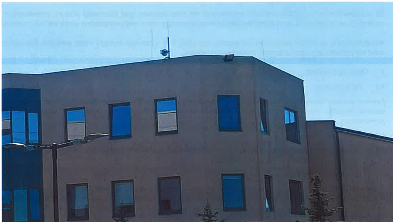
Zdjęcie 1 Badany obiekt
