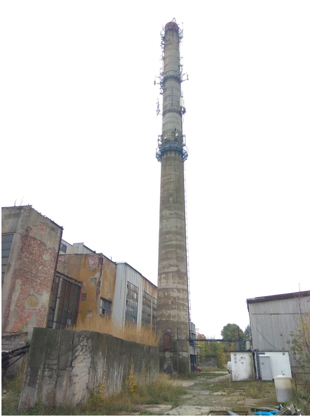
Widok obiektu wraz z zainstalowanym zespołem antenowym
