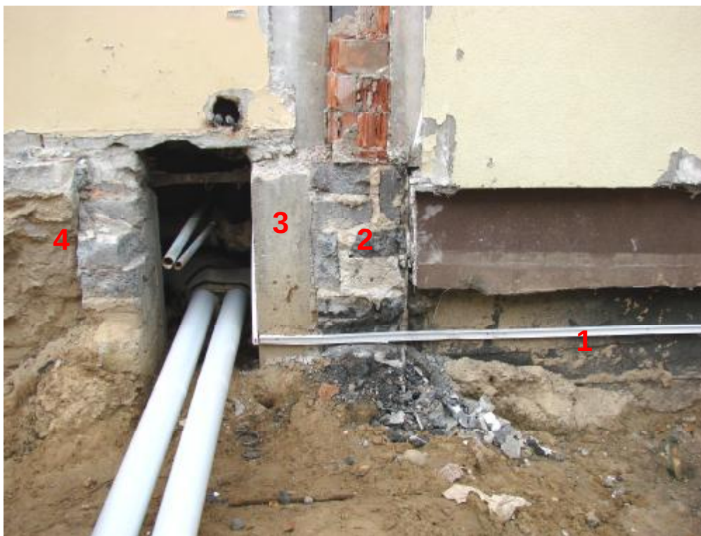
Fot. 5 Widoczne zróżnicowanie materiałów w których wykonane są ściany fundamentowe. Patrząc od prawej, fundament (1) wykonany z betonu wylanego w szalunkach, następnie pod słupkiem (2) ściana murowana z bloczków żużlobetonowych, dalej (3) wylewana w szalunkach betonowa i na koniec wylewana w gruncie również betonowa.
