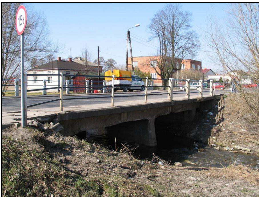
Fot. 2. Widok obiektu z boku od strony DW.
