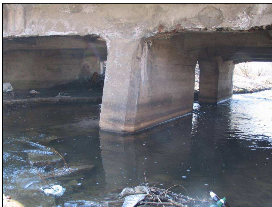
Fot. 6. Przestrzeń podmostowa – koryto rzeki wraz z filarem nurtowym.
