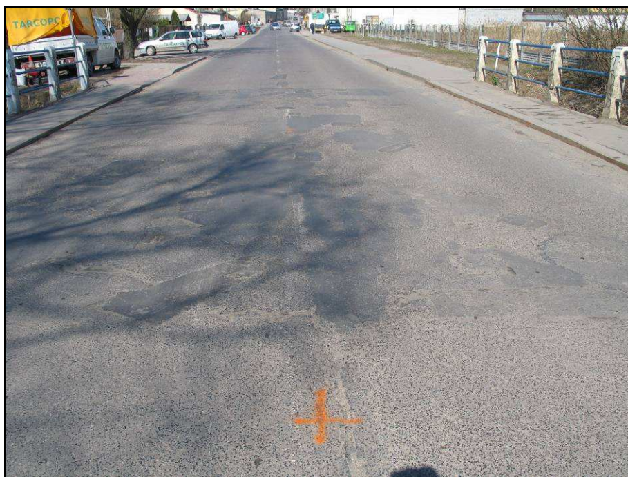
Fot. 4. Widok w kierunku Centrum Tarczyna - góra obiektu wraz dojazdem od strony Tarczyna.
