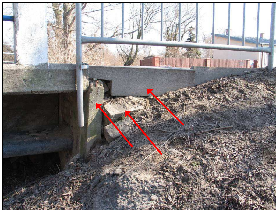
Fot. 22. Widoczne betonowe prefabrykaty zastosowane za wspornikiem ustroju nośnego oraz na krawędzi chodnika na dojściu do mostu.
