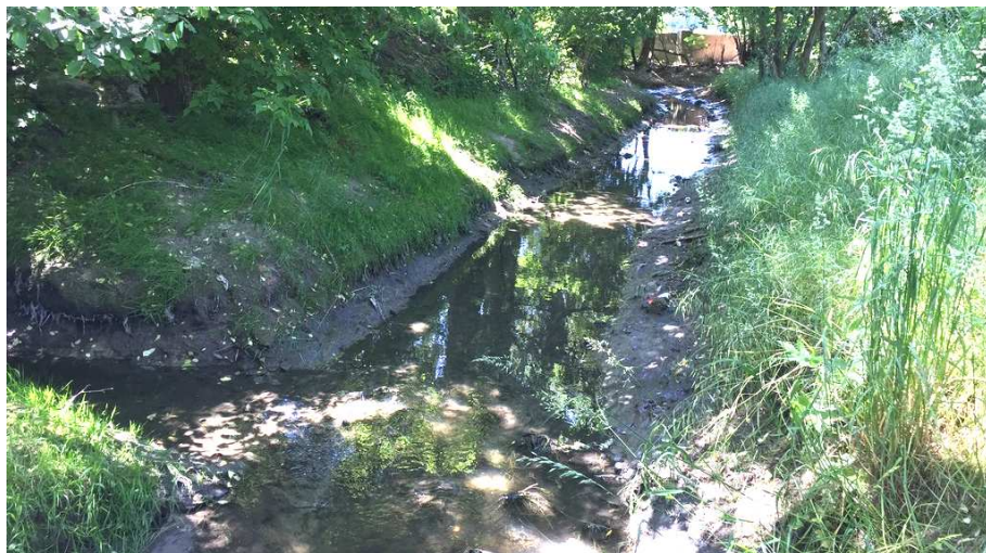
Rys. 5 Koryto Kanału P. powyżej istniejącego mostu drogowego. Widoczne ujście rowu odwadniającego teren na prawym brzegu.
