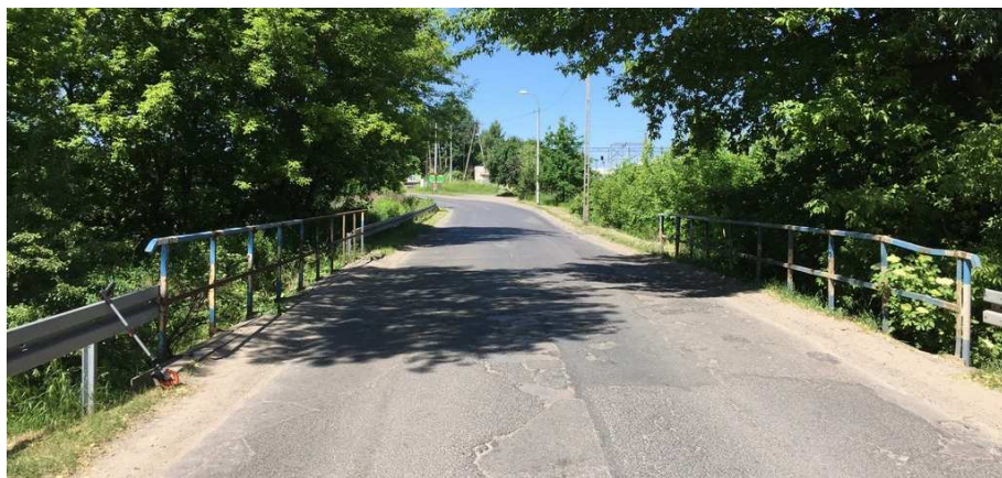
Rys. 3 Widok istniejącego mostu w ciągu ul. Jana Pawła II
