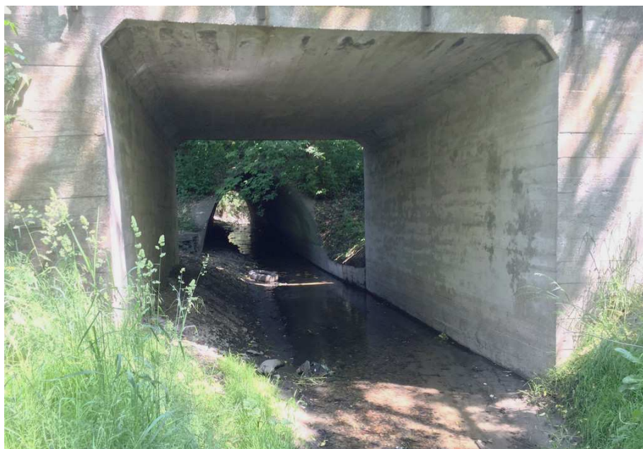
Rys. 4 Widok z boku istniejącego mostu drogowego. W głębi widoczny przepust kolejowy.
