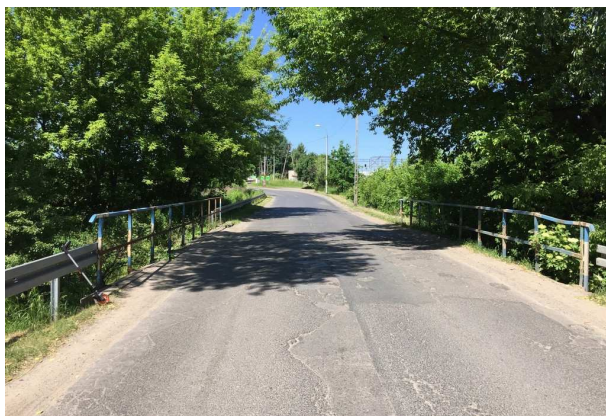
Fot. 1 Widok istniejącego mostu w ciągu ul. Jana Pawła II
