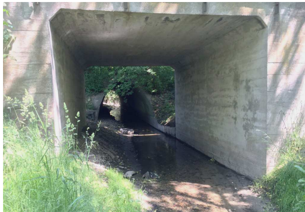
Fot. 2 Widok z boku istniejącego mostu drogowego. W głębi widoczny przepust kolejowy.
