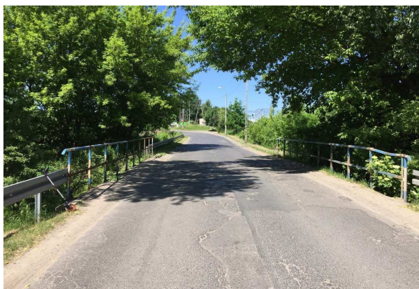
Fot. 1 Istniejący most drogowy w ciągu ul. Jana Pawła II: widoczne lekkie balustrady stalowe z kątowników.
