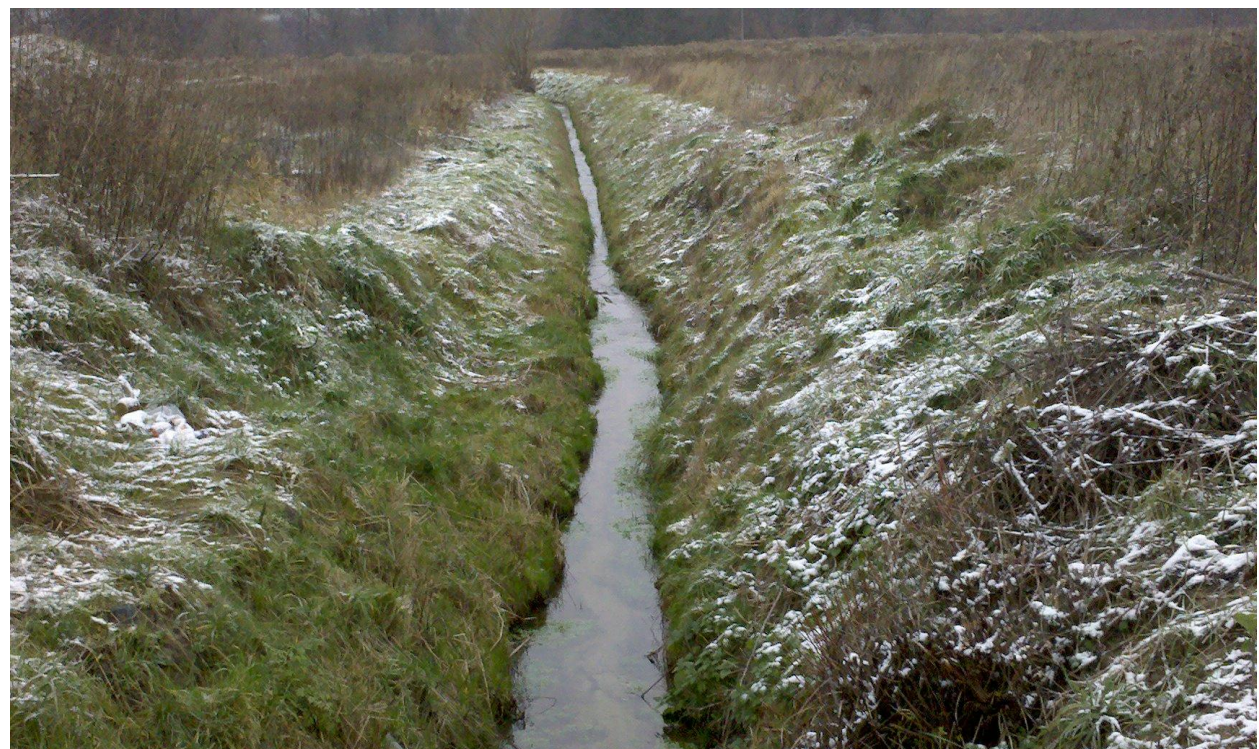
Fot. 10. Ciek od strony wschodniej w okresie zimy. Brak nieprawidłowości.
