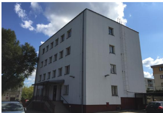
Widok elewacji frontowej N i szczytowej W
