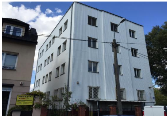
Widok elewacji tylnej S i szczytowej E
