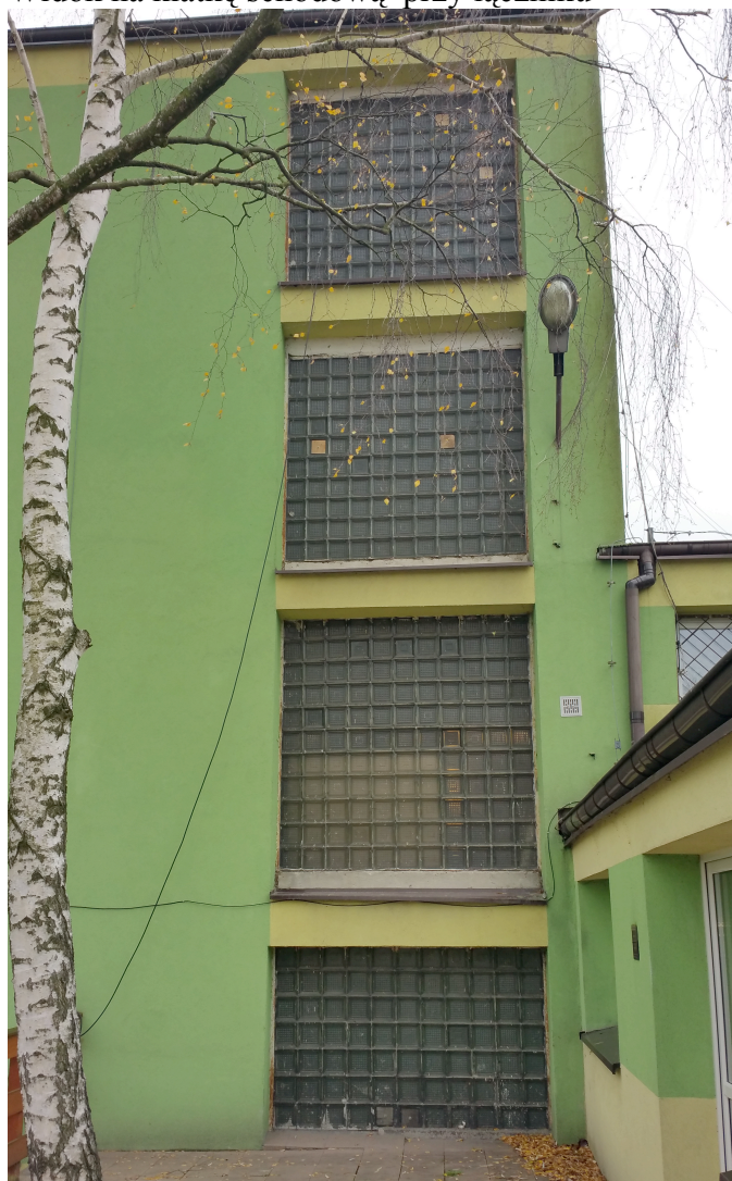
Widok na klatkę schodową przy łączniku
