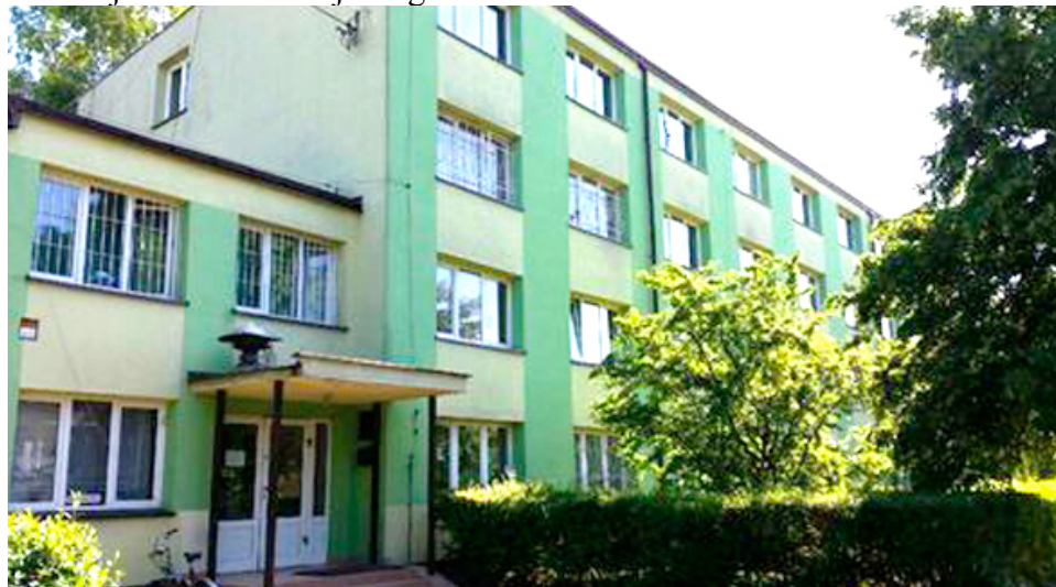
Elewacja frontowa- wejście główne
