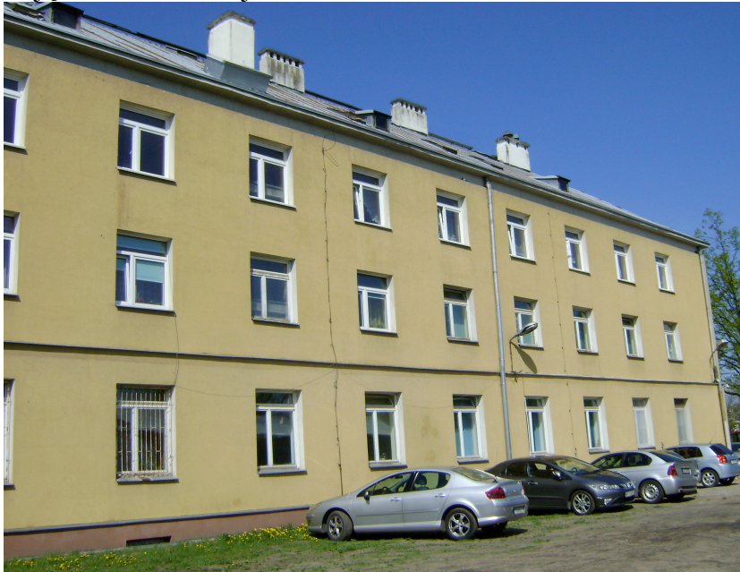
Zdjęcie nr.1- Elewacja wschodnia
