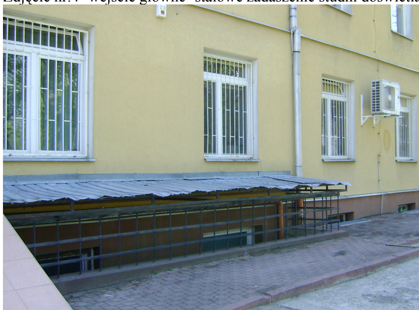
Zdjęcie nr.4- wejście główne- stalowe zadaszenie studni doświetlającej
