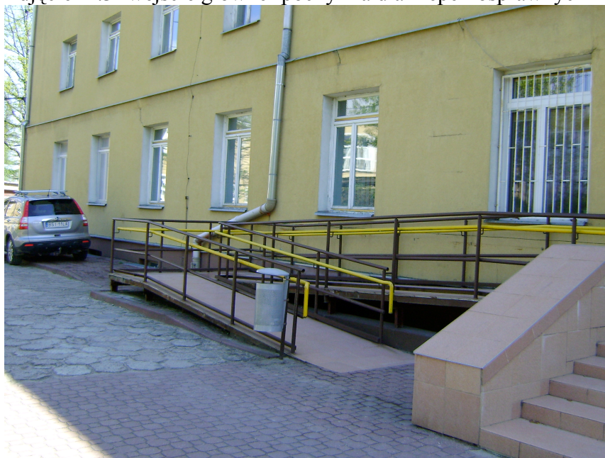
Zdjęcie nr.3- wejście główne- pochylnia dla niepełnosprawnych
