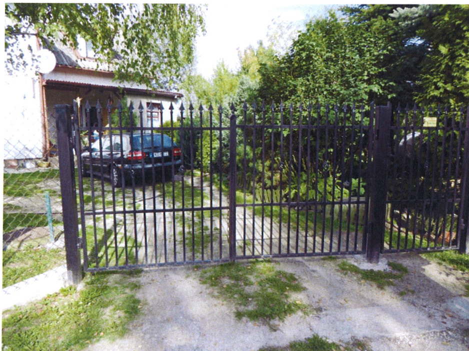
Fot. Skrzydła bramy do przeniesienia.
