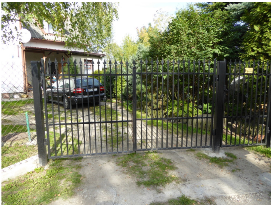
Fot. Skrzydła bramy do przeniesienia.
