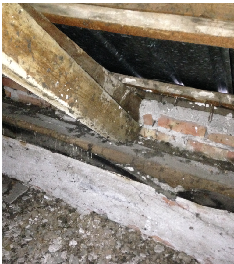
Zdj.4 Poddasze- więźba- murlata.
