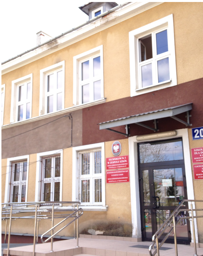
zdj.1 Elewacja wejściowa- fragment
