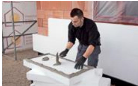
Rys. 3. Sposób rozprowadzania kleju na płycie ocieplenia
