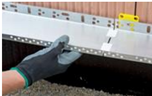
Rys. 1 Listwa startowa ocieplenia ścian osłonowych
