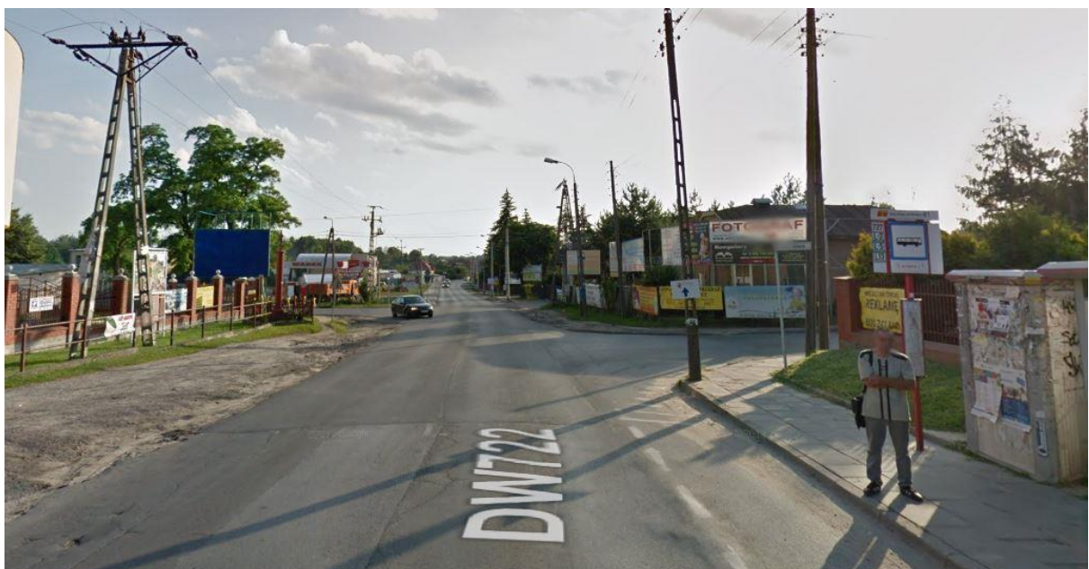
Fotografia nr 2 (ul. Pod Bateriami – kierunek Tarczyn)
