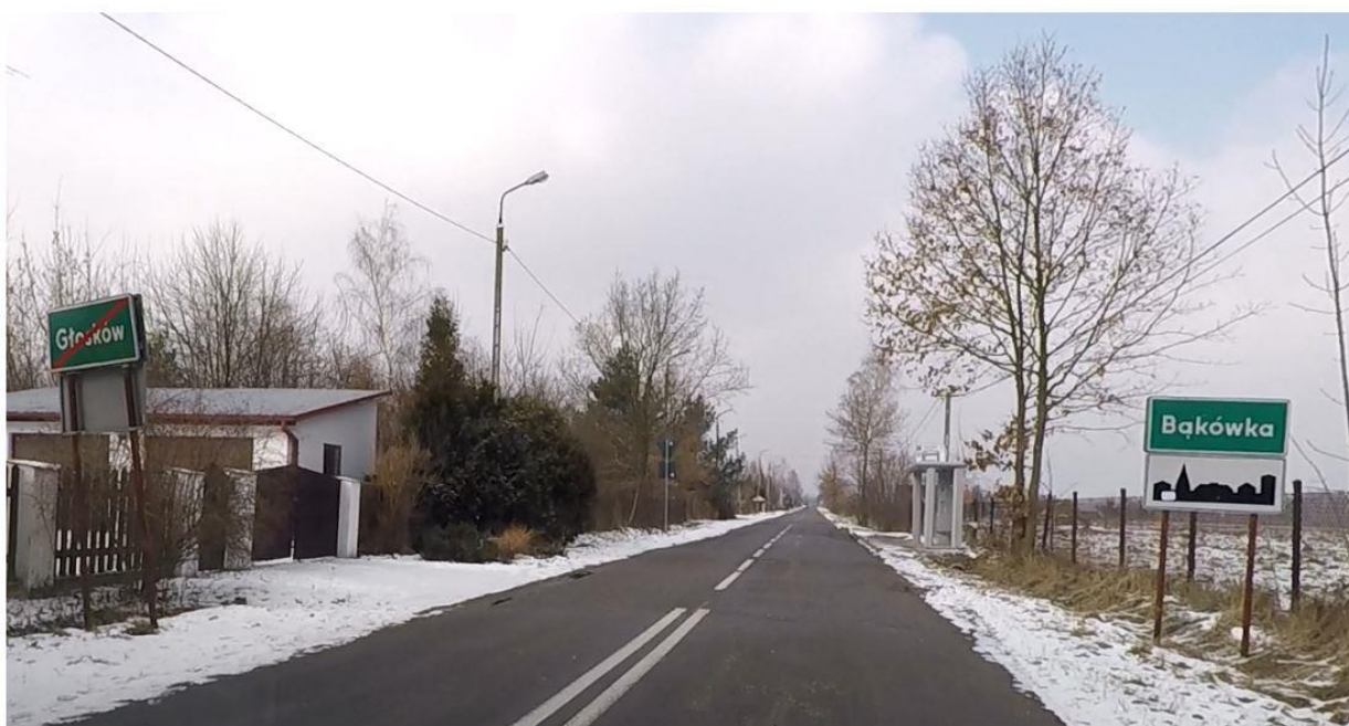
Fotografia nr 2 (ul. Asfaltowa – kierunek ul. Lipowa)
