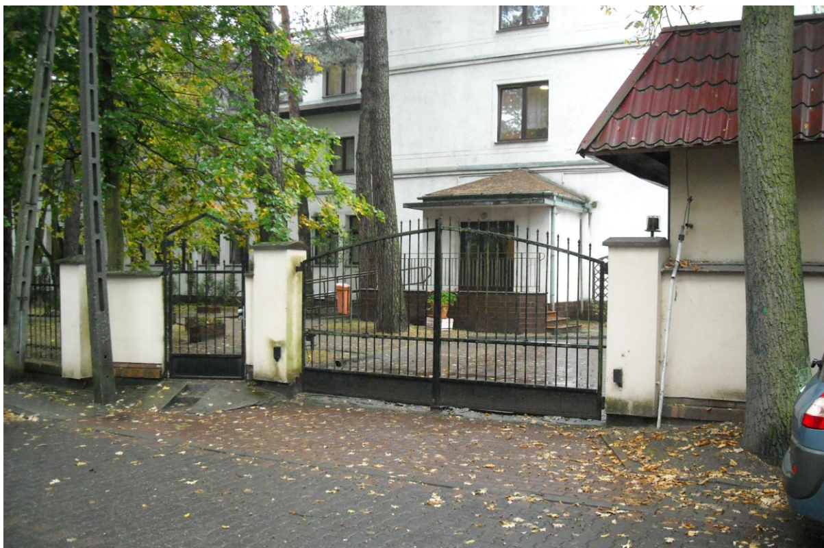
Fot. 2. Brama wjazdowa na teren wewnętrznych parkingów od ul. Rycerskiej. Brama i furtka umożliwia wprowadzenie ekip ratowniczych do jednego z głównych wejść do budynku nr 4.
