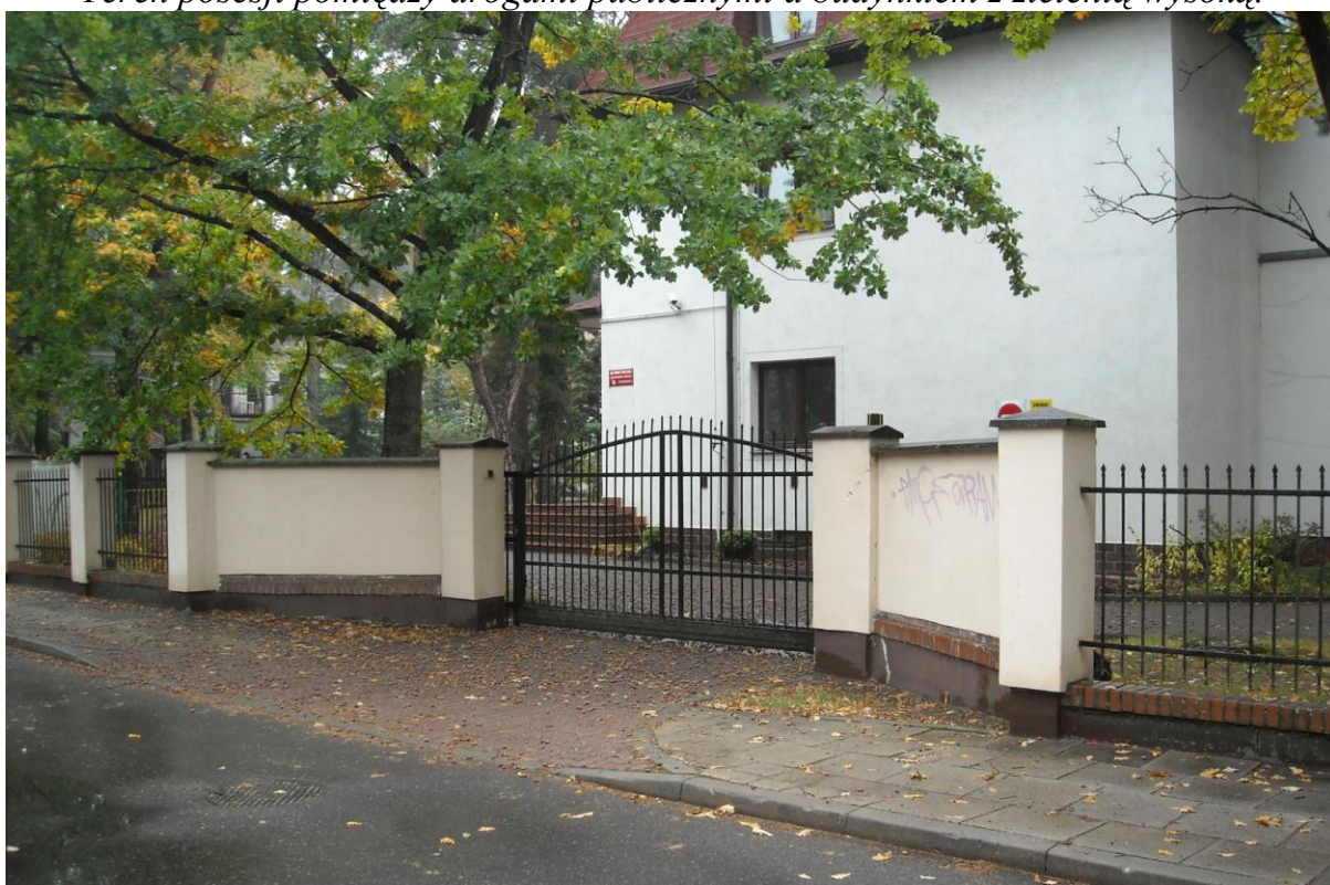
Fot. 4. Widok na budynek nr 3 z ul. Potulickich. Brama umożliwia wprowadzenie ekip ratowniczych do głównego wejścia do budynku nr 3 (klatka schodowa).
