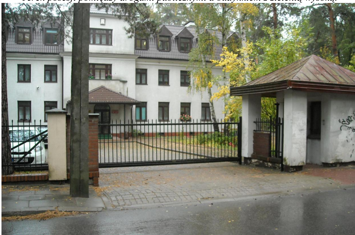
Fot. 6. Brama wjazdowa na teren wewnętrznych parkingów od ul. Chylickiej. Brama i furtka umożliwia wprowadzenie ekip ratowniczych (pojazdów pożarniczych) do jednego z wejść do budynku nr 1.
