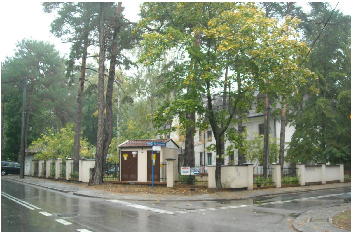
Fot. 5. Widok na budynek nr 1 ze skrzyżowania ulicy Potulickich i ulicy Chylickiej. Teren posesji pomiędzy drogami publicznymi a budynkiem z zielenią wysoką.
