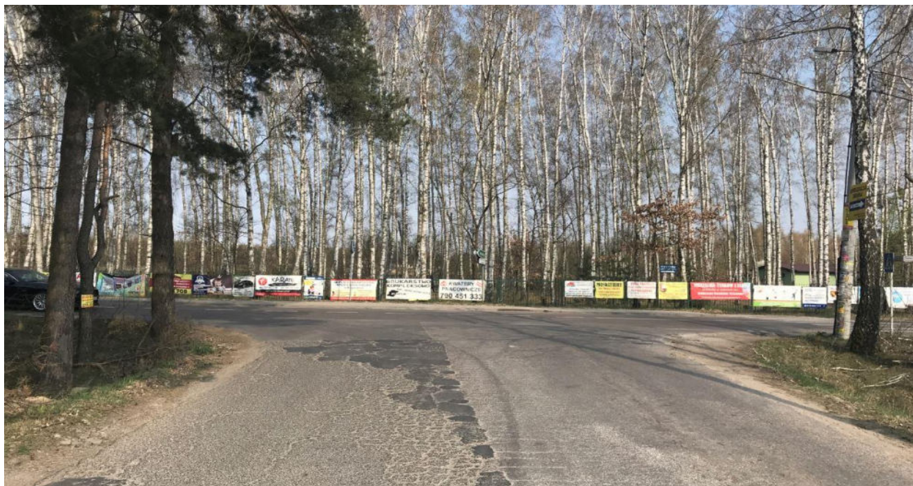
Fotografia nr 1 (ul. Masztowa – rejon skrzyżowania z ul. Gościniec/Wojska Polskiego)
